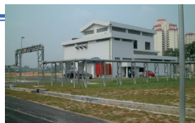
図1. マレーシアPuchong 下水処理場汚泥脱水機棟
