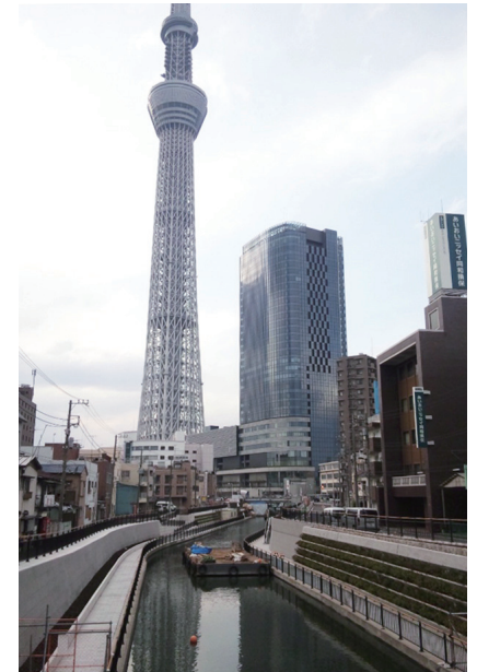
東京スカイツリーと北十間川 このすぐ下がシールド横断の現場
