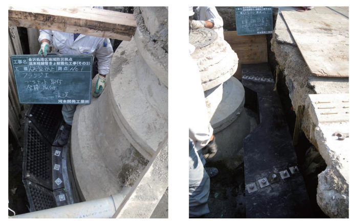
4種マンホールの半周だけに取り付けられたフランジと金枠 残りの重量を補完するために設置された金属プレート
