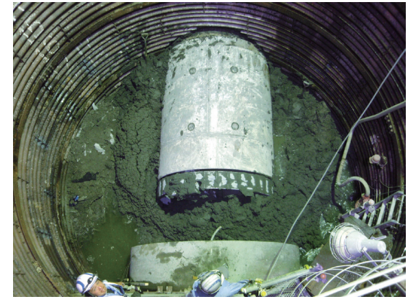
中間立坑から見たシールドマシン 手前が刃口推進工法で掘削した坑口
