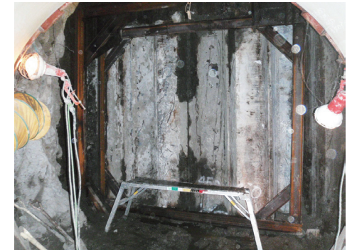
矢板の開口部も鋼材で補強
