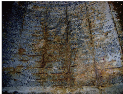
マンホールの劣化実態（腐食事例）
