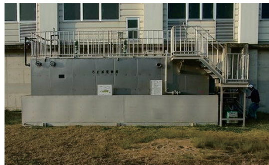
図-1 汚泥減量設備全景写真
