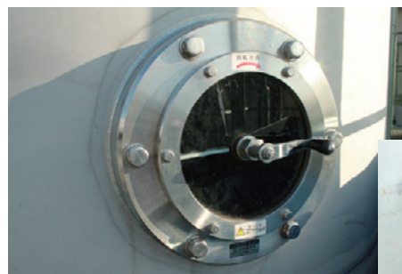
ブロック状況が見られる点検窓
