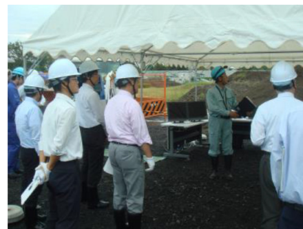
現場立会試験
