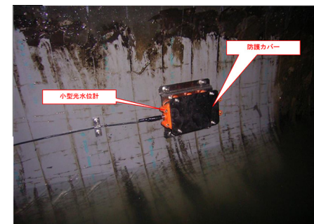
小型光水位計設置状況
