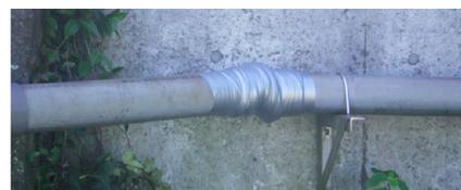
応急対応として抜け出しを止水テープで固定（補修前）
