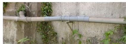
抜け出し部に管を追加（補修後）
