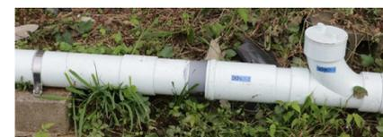
気温により管が伸縮するため、ヤリトリ継手を設置
