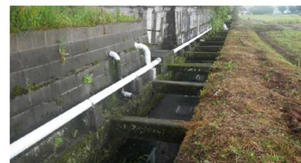
管の入れ替えで、半日で補修完了（補修後）
