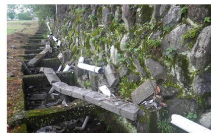
地震で民地のブロック塀が落ちてきて破損（補修前）
