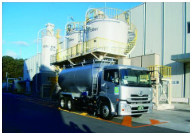
発電所内に設けられた炭化燃料貯留設備とホッパー車
