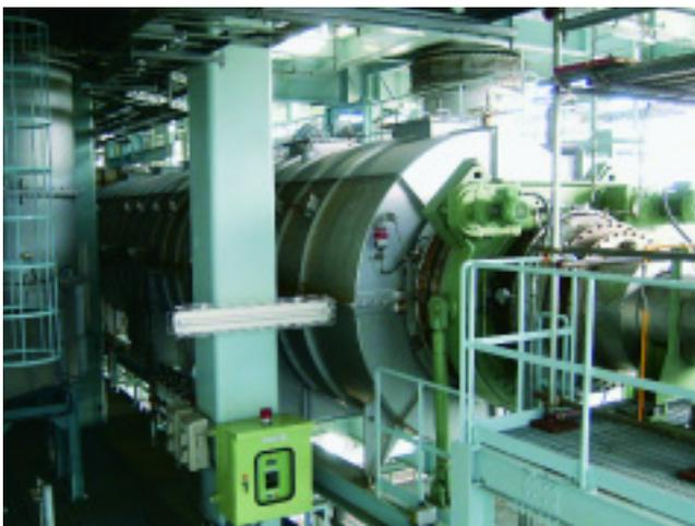
汚泥の投入口側から見た炭化炉
