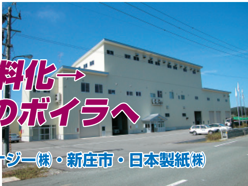
汚泥の燃料化が行われているバイオソリッドエナジー(株)の実証プラント
