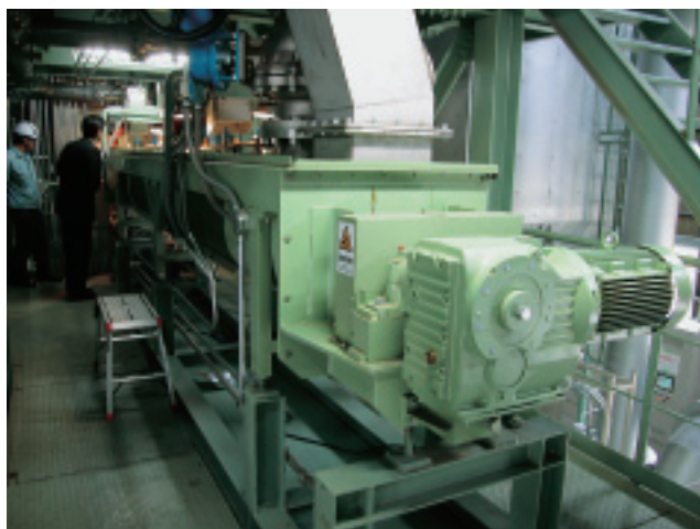
脱水汚泥を効率的に造粒する二軸ミキサー
