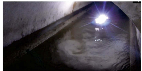
写真-5 調査状況 (下流側より撮影)
