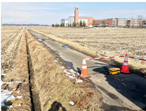
写真-4 フィールドG 周辺状況
