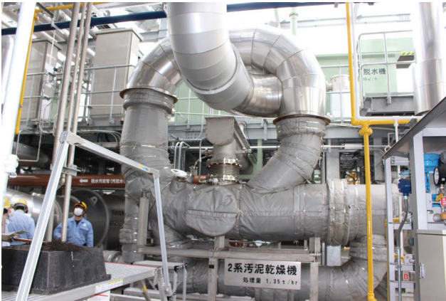
写真-2 円環式気流乾燥機
