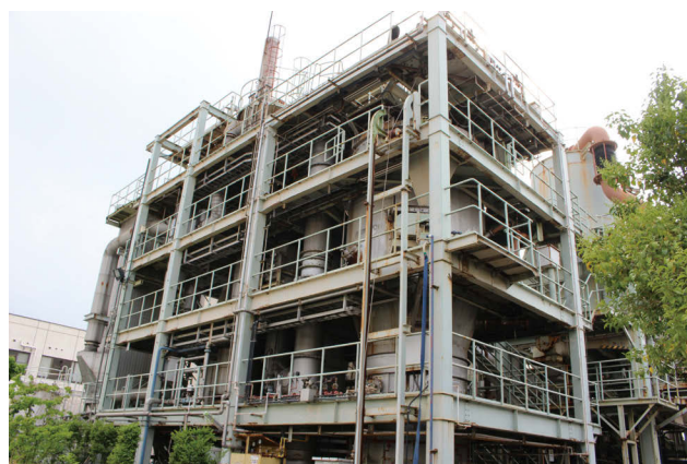
写真-1 廃止となった焼却炉
