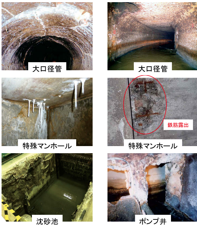
図-1 想定される調査困難箇所（気相部）
