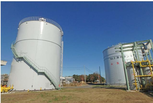
写真-2 ガスホルダ（左）と消化タンク（右）
