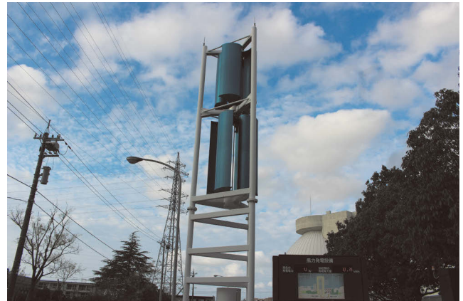
写真—2 風力発電設備
