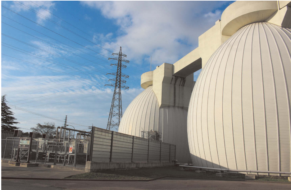
城北水質管理センターの消化タンク
