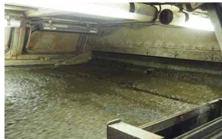
ベルト型汚泥濃縮機の内部
