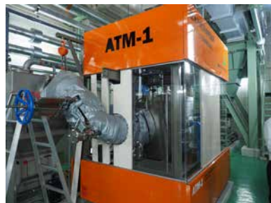
マイクロ波を照射する汚泥前処理装置
