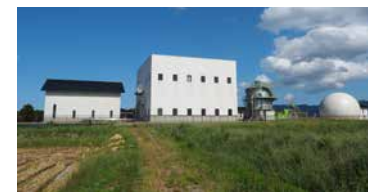
右から、ガスタンク、メタン発酵槽、受入・前処理棟、汚泥処理棟がコンパクトに並ぶ
