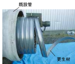
図2 自立管 製管工法（ら旋巻管）の例
