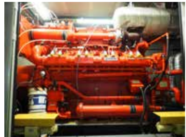
消化ガス発電機 (都南浄化センターの使用電力の約3割を賅っている)
