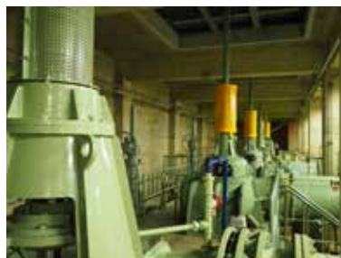
汚水ポンプ (効率の良い範囲での運転を徹底)
