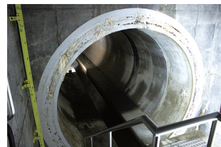
写真-1 下川原雨水貯留管内部
