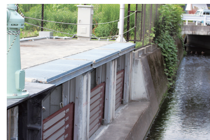
写真-2 2号取水施設取水口
