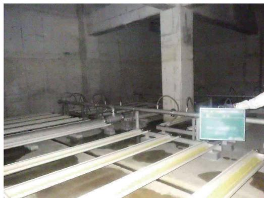
低圧損型メンブレン式散気装置
