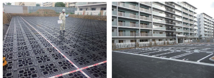
コンフォール茅ヶ崎浜見平での施工風景(左)、上部利用状況(右)
