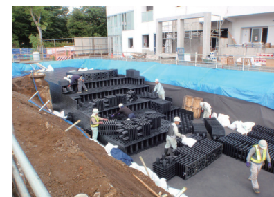
人力による施工が可能 (シンシンプロック株式会社提供)
