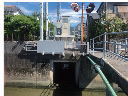
写真-1 紅水川3号水門状況
