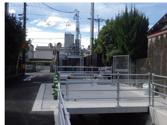
写真-3 初月2号補完ポンプの設置状況
