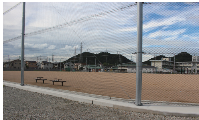
糸引公園雨水貯留施設の上部利用の様子
