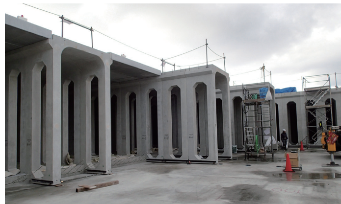
プレキャスト式で施工
