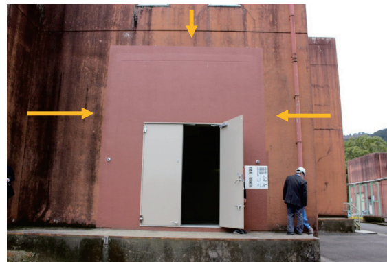
写真-4 設置した耐水扉 (補強した箇所は外壁の色が異なっている)
