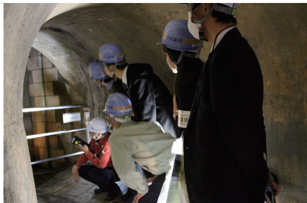
旧三河島污水処分場唧筒（ポンプ）場
