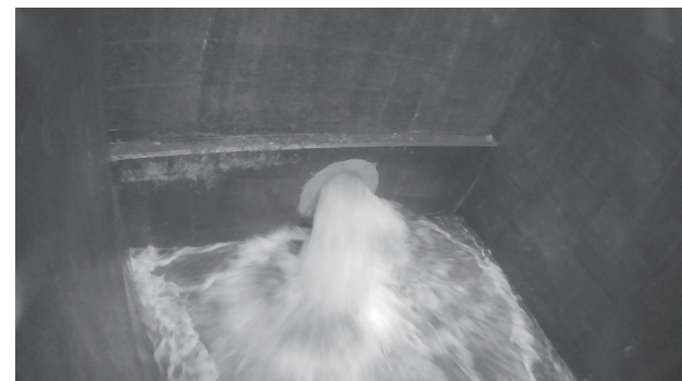
写真-2 ボルテックスバルブからの排水の様子
