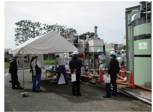
立会確認状況
