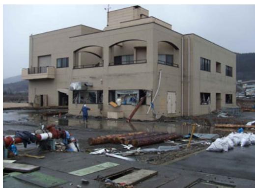
大船渡浄化センター(建築)
