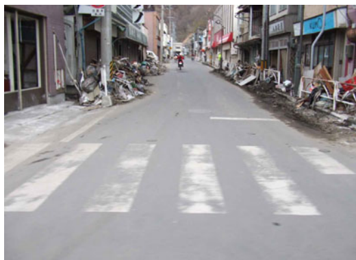
宮古市街(宮古処理区)被害小
