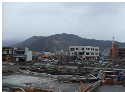
大船渡市沿岸部の被災状況
