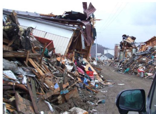
宮古市街(田老処理区)被害大
