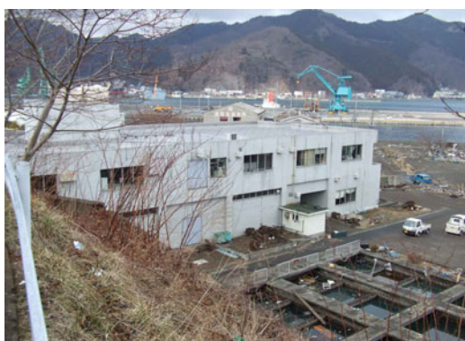
釜石市大平浄化センター(管理棟、初沈) 管理棟2Fを使用している
