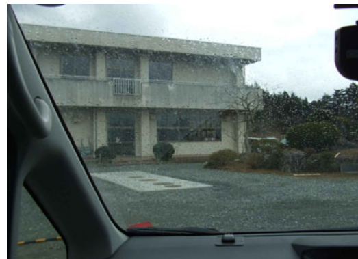
②陸前高田市の高台(竹駒小、浄化槽)
