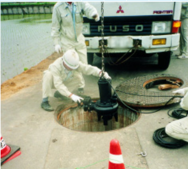
クレーンでつり上げられ、マンホール内に降ろされるポンプ設備
