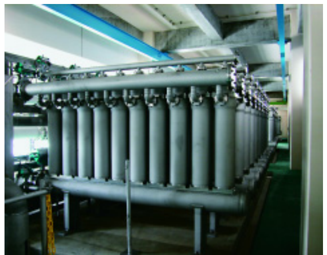
100本のエレメントをステンレス管で接続したものが1ユニット
