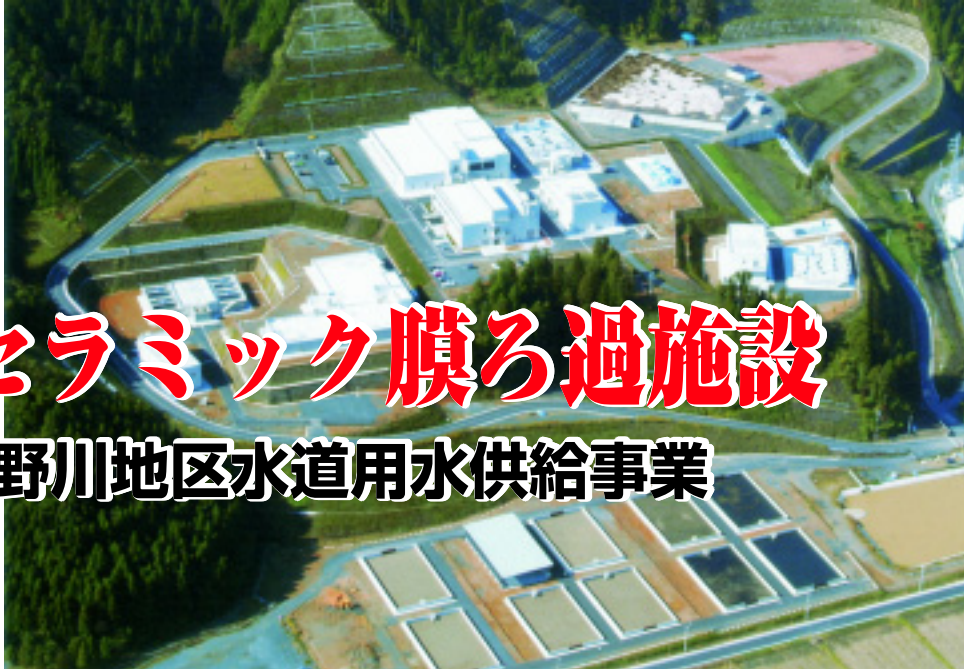
王子保浄水場の全景。手前に見えるのは脱水ケーキの天日乾燥床
