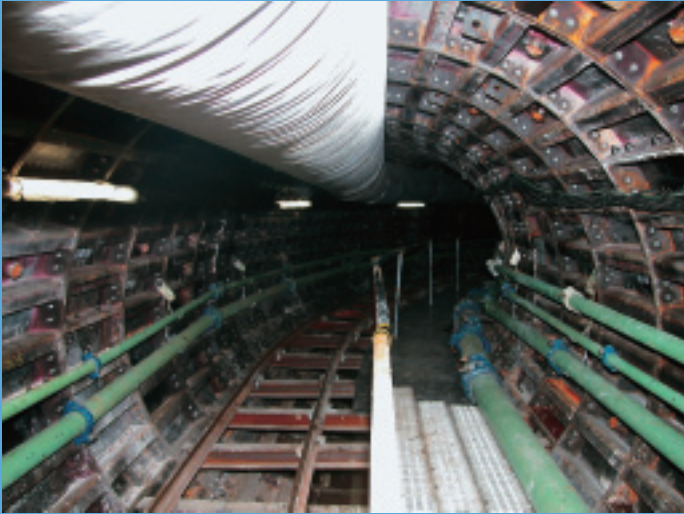
充填式シールド急曲線工法
