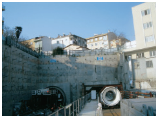
シールド工事アジア側発進現場
