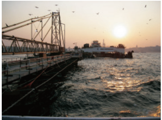
ボスポラス海峡の沈設現場
