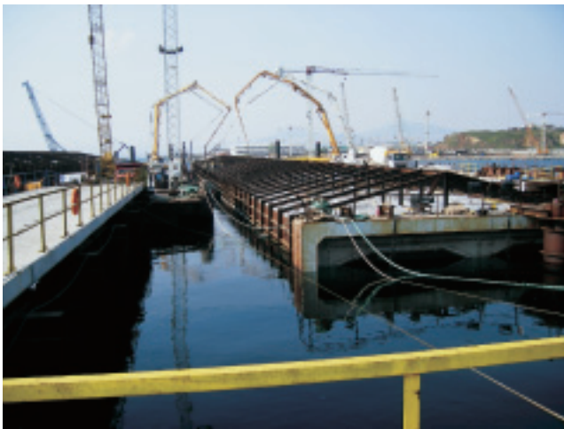
沈埋函体の製作ドック
