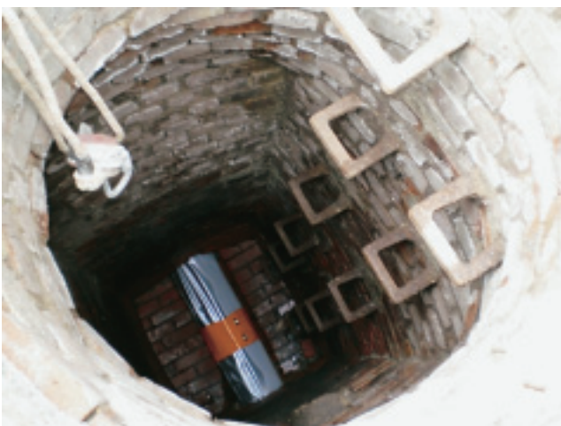
中間マンホールから見たライナーの状況。オレンジ色の部分からテストピースを採取。
