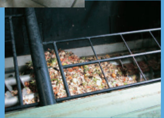
機械棟に設置されたし尿の投入口
