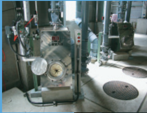
機械棟に設置されたし尿の投入口
