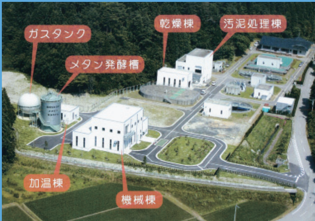
バイオマスメタン発酵施設が建設された珠洲市浄化センター
