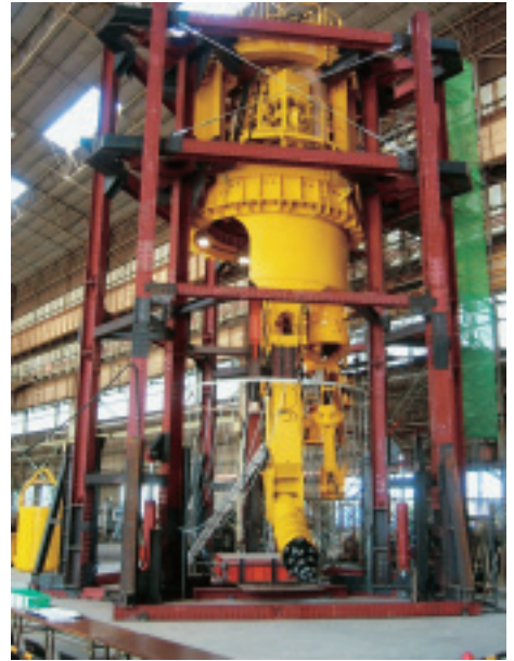
換気立坑で使用されている自由断面掘削機
