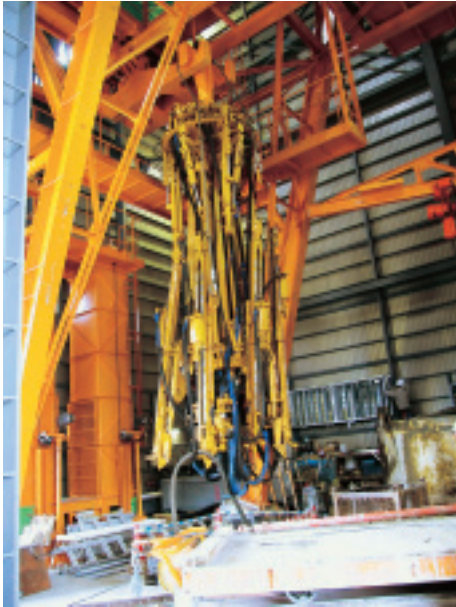
東立坑の掘削に使用されているジャンボ削孔機
