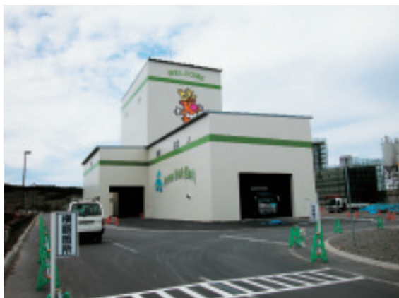
東立坑の外観。冬場の工事に備えて建屋内に納められている
