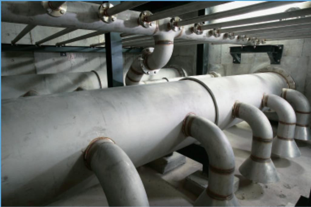
洗浄排水を集める高速洗浄装置の集水部
