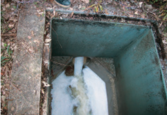
勢いよく減勢装置に流れ込む下水
