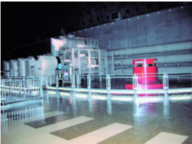
水力発電の常識を変えたスプリッターランナ
