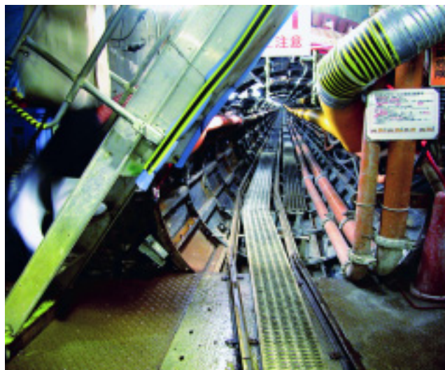
立坑から見た現在施工中の上流側トンネル
