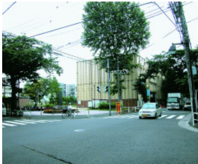
公園の脇に静かにたたずむ東京都水道局の発進立坑基地
