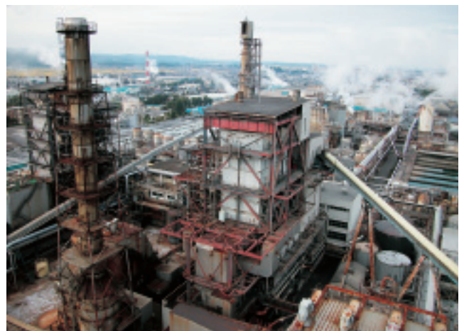
汚泥燃料を使用している巨大な石炭ボイラ
