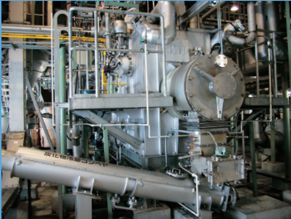
順調に稼働する中条浄化センター活性炭化設備の炭化炉
