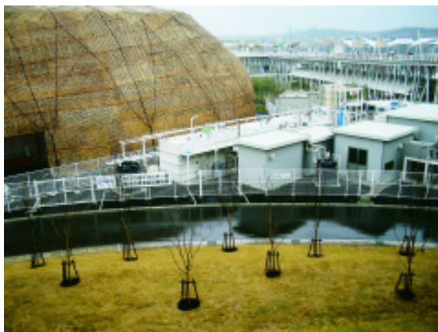
写真 愛知万博実証実験（省エネルギー水処理技術 の開発・NEDOプロジェクト）
