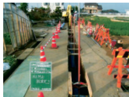
流動化処理土の管きょ施工への利用例
