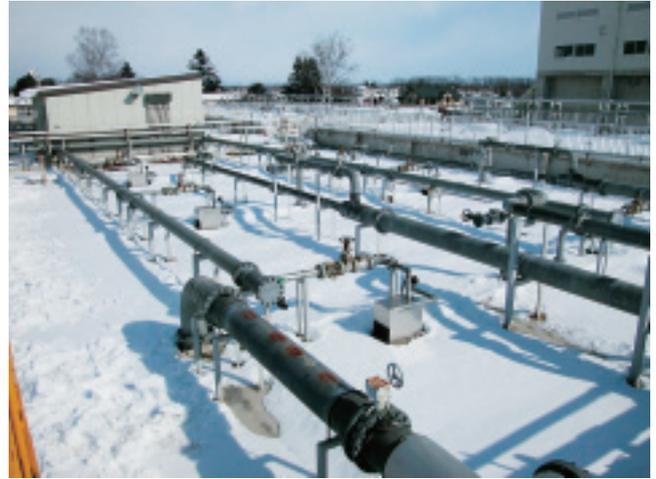
膜分離槽からの処理水を汲み上げる配管が並ぶ
