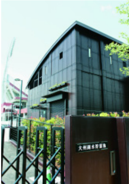
周辺環境の調和も考慮した搬入棟
