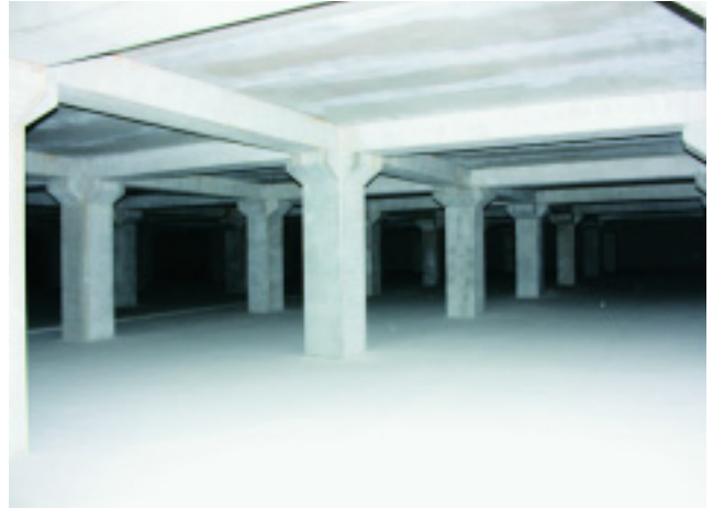
まるで地下宮殿のような貯留池の躯体
