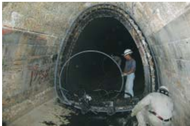
ロサンゼルス市・JOAフレーズⅠ工事（施工中）
