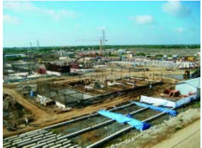
コンポスト施設から水処理施設を臨む（工事中）
