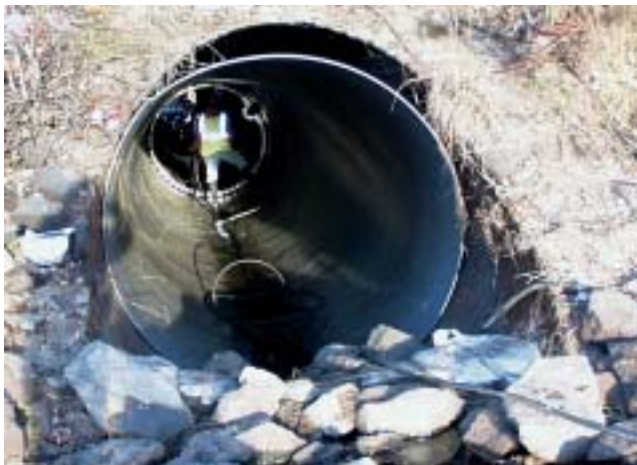
高速道路下横断管施工（施工中）
