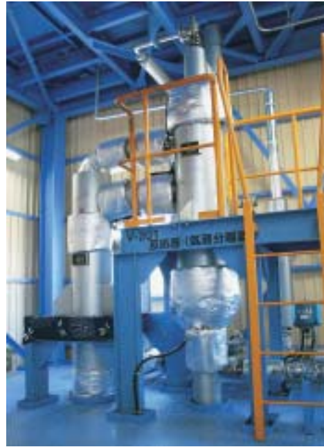
このプラントの心臓部である亜臨界水処理反応器
