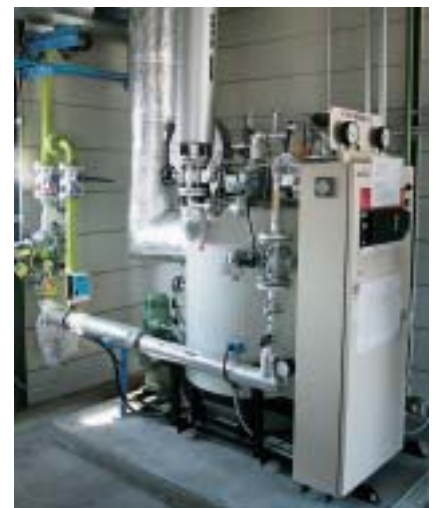
熱媒ボイラでメタンガスを燃やし、 反応器に熱エネルギーを供給する
