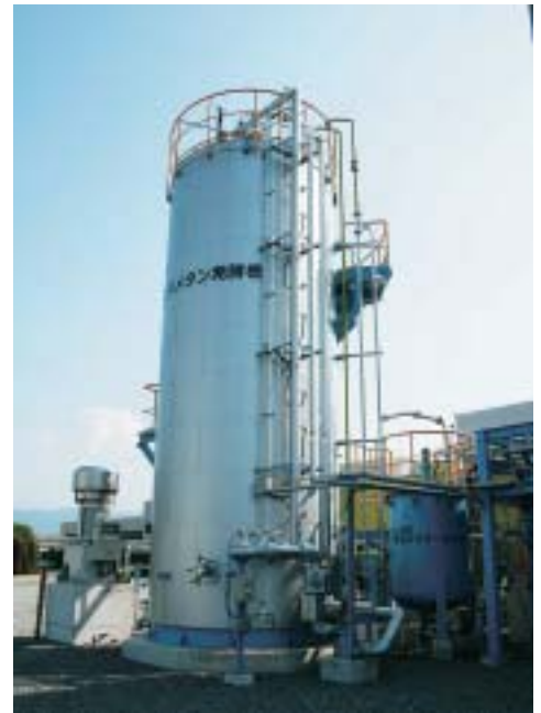
55℃の高温発酵を特徴とする高速・高効率のメタン発酵装置
