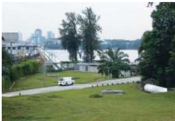
マレーシアからの送水管 (対岸はマレーシア・ジョホールバル)
