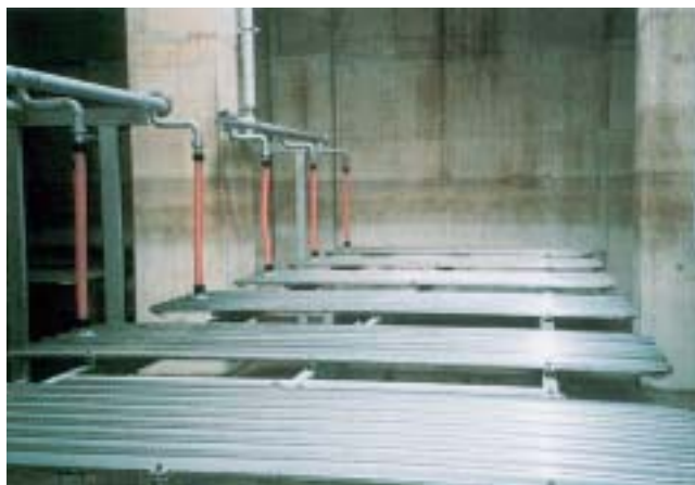
直径1mmの気泡を産みだす散気パネル
