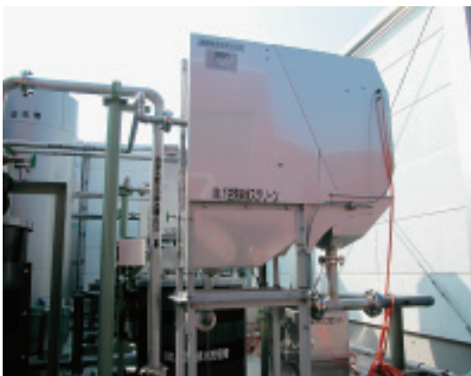
セラミック膜をケーシングした膜モジュールを1系統に3本使用している
