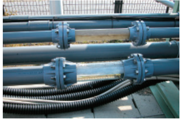
透明パイプを使って「見える化」の取り組みも
