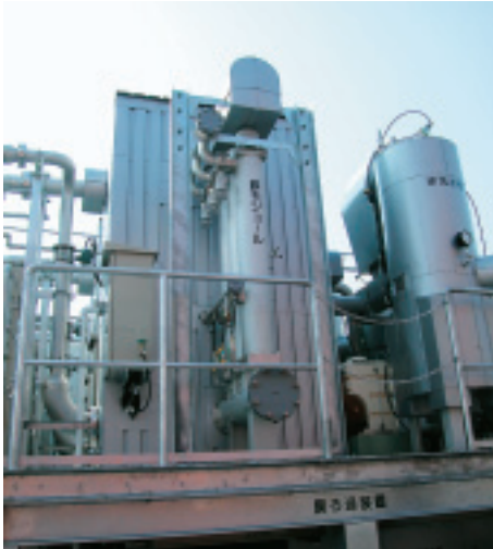
セラミック膜をケーシングした膜モジュールを1系統に3本使用している
