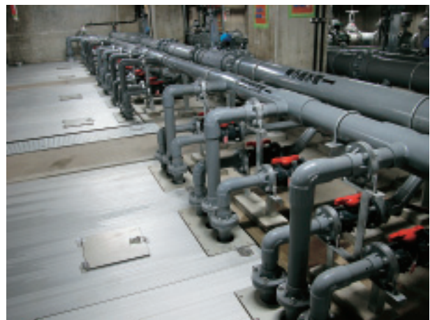
中央の送気管を挟むように膜ろ過された処理水の送水管が並ぶ
