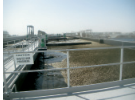
写一 2 ドーハ西下水処理場総合試験運転状況
