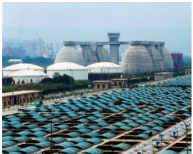
台湾八里下水処理場
